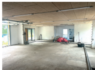
Der zukünftige Bauhof von innen
