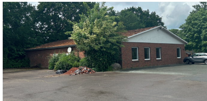
Das alte Gemeindehaus vorm Abriss am 10. Juni ...
