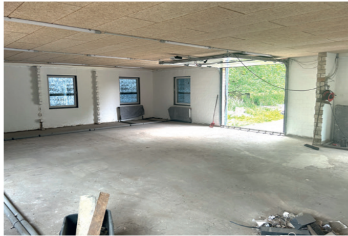
Jetzt kommt auch der Trecker ins Gebäude
