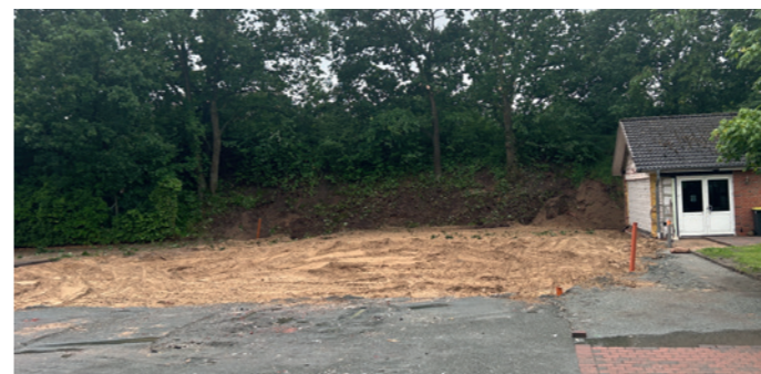
... und schon ist das alte Gebäude Geschichte am 21. Juni 2024.
