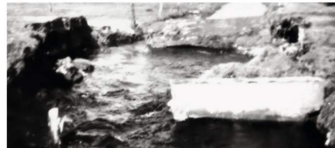
Ein Graben (Nebenarm des Schafflunder Mühlenstroms), welcher direkt am Haus Dibbern verläuft. Dort ist 1933 eine Brücke weggespült worden.
